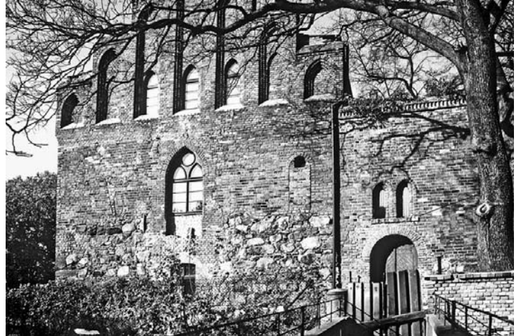
Ansicht von Südosten
