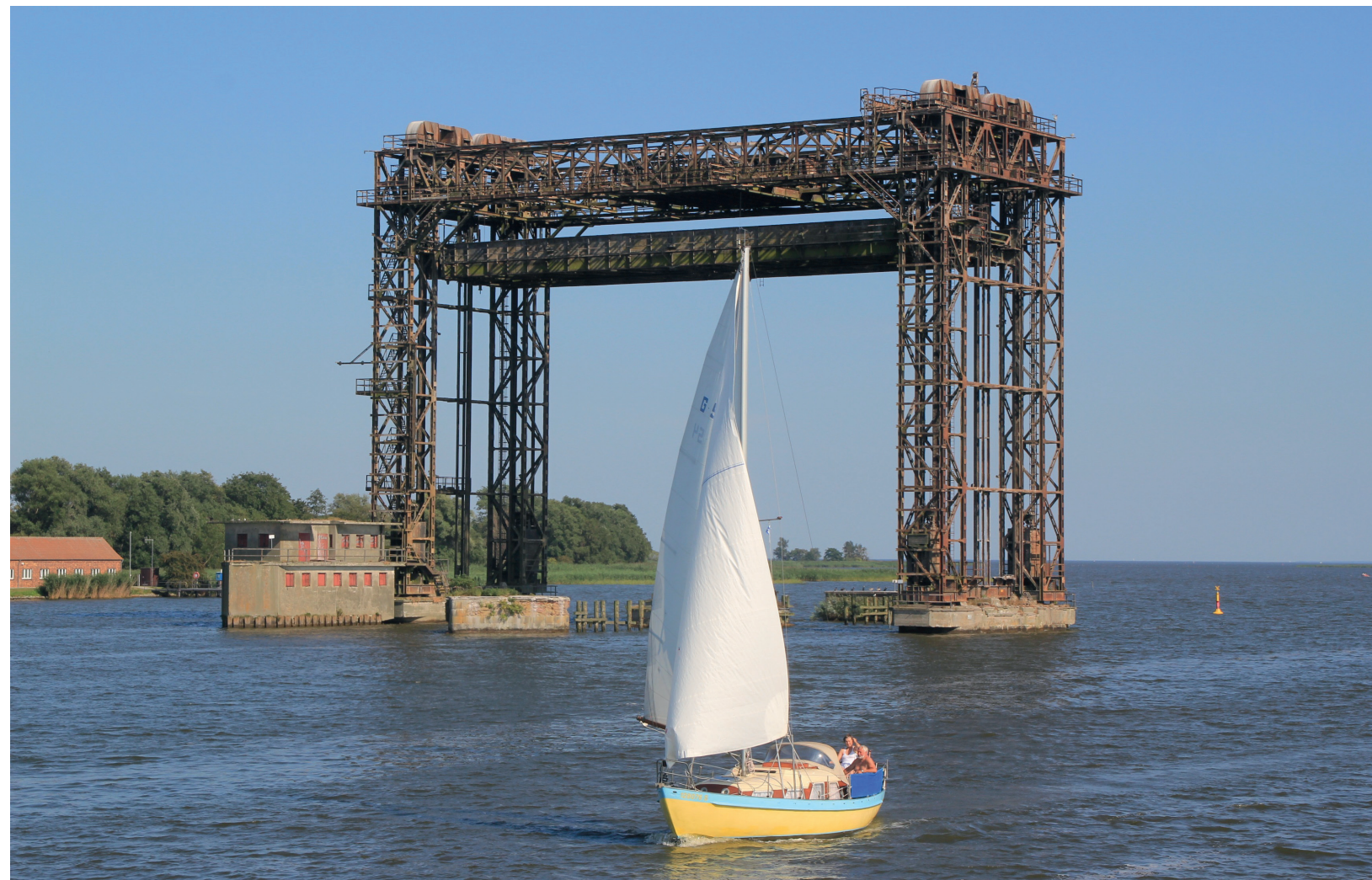
Der jetzige Zustand der Karniner Brücke (Foto: Peer Schmidt-Walther)
