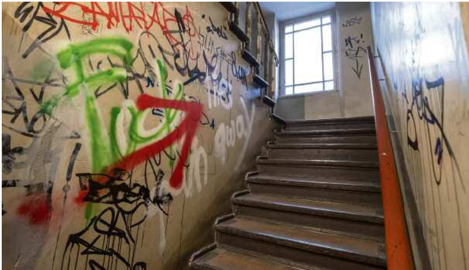
Verwahrlosung allgegenwärtig: Treppenhaus in Berlin
