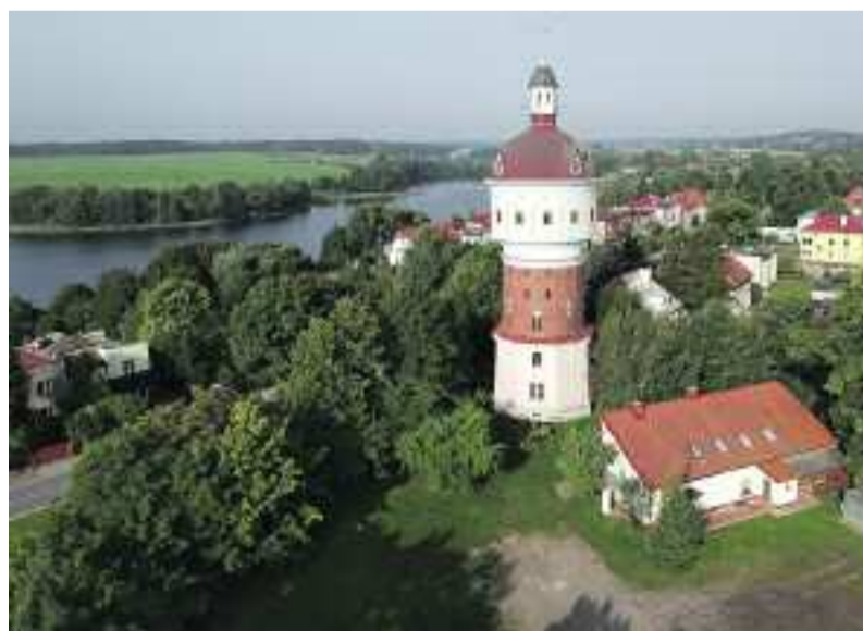
Eine Augenweide: Restaurierter Wasserturm
