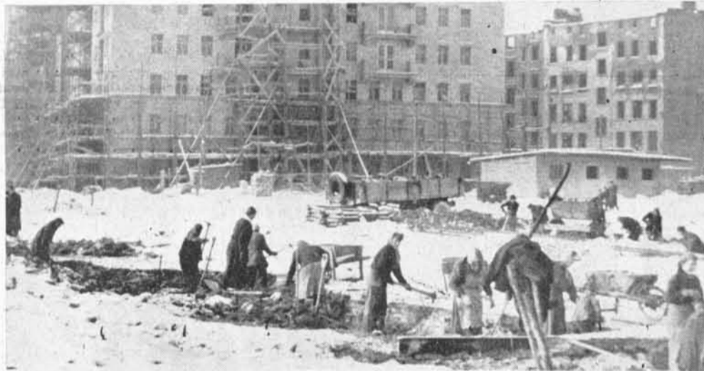
Nach sowjetischem Vorbild sind auch „Frauenbrigaden“ auf den Baustellen beschäftigt. Mit Pickel und Schaufel müssen sie ein „Uebersoll“ im Dienste der SED leisten.
