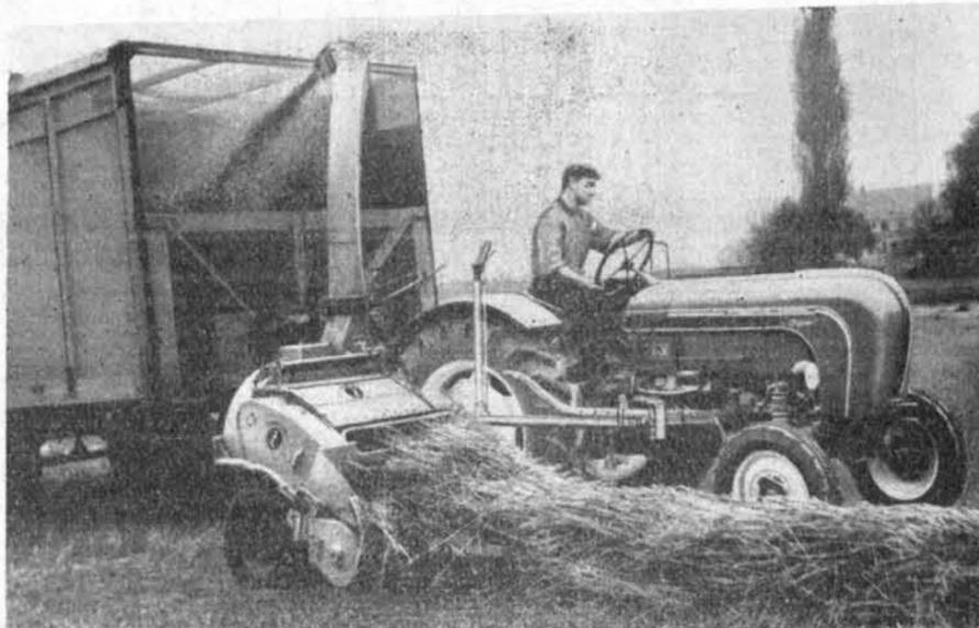
Mit dem Feldhäcksler kann man bei Einmannbedienung jedes Erntegut, vom zeitigen Frühjahr bis zum Rübenblatt, Markstammkohl und Kartoffelkraut im Spätherbst, gehäckselt eingebracht werden. Der Feldhäcksler wird zum vielseitigen Gerät zum Aufsammeln, Laden und Fördern.
