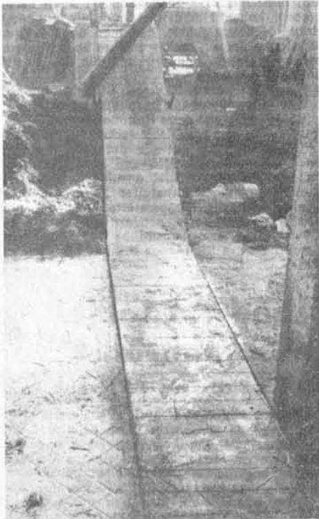
Zweireihe Schubstangenförderung, die den Mist in einen quer dazu verlaufenden weiteren Kanal transportiert.
