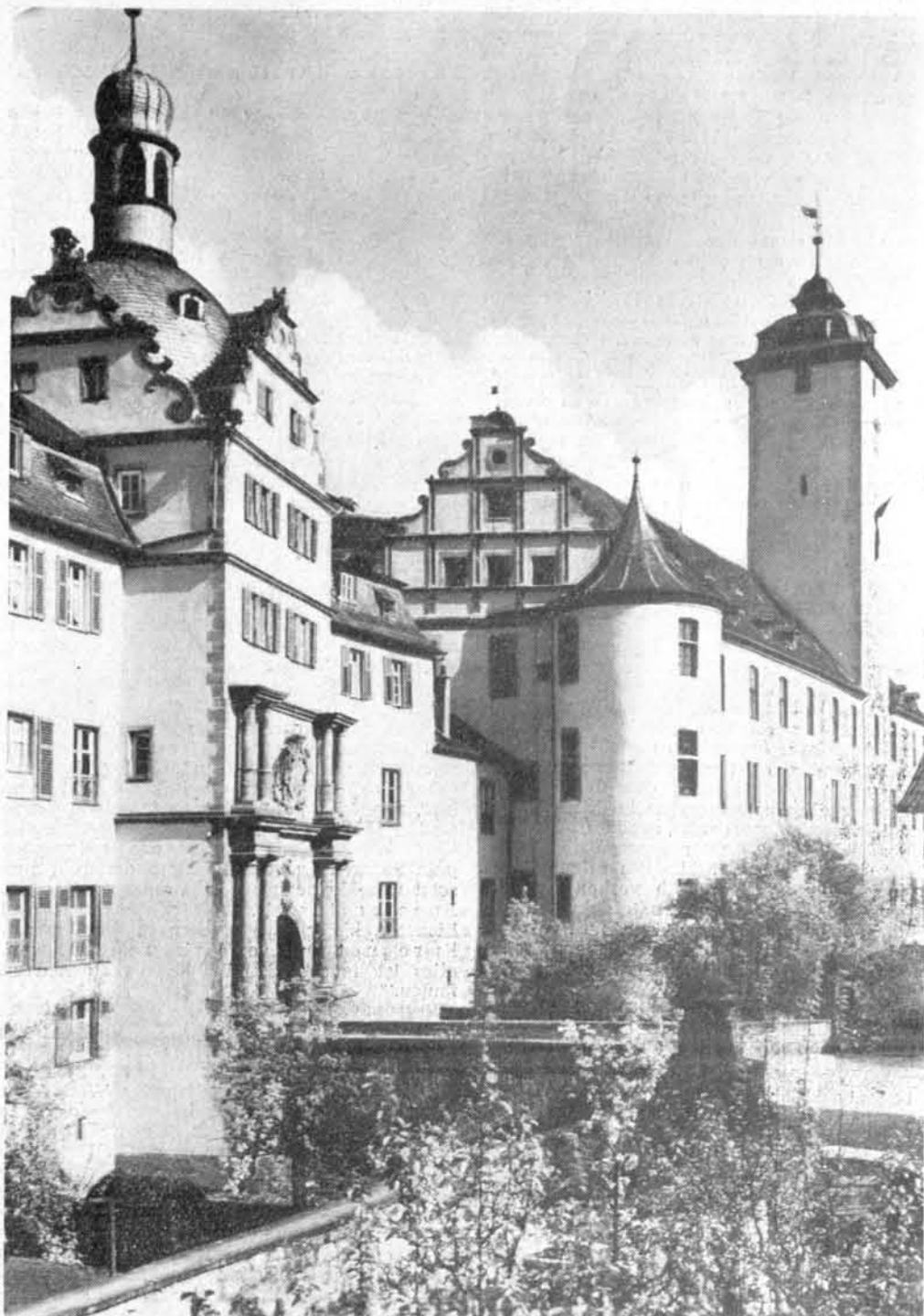
Das Deutschordensschloß in Mergentheim
