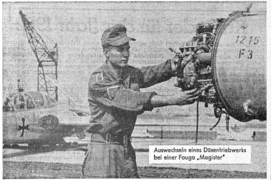
Auswechseln eines Düsentrriebwerks bei einer Fouga „Magister“
