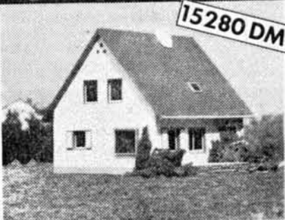
Vorgefertigtes massives Einfamilienhaus Typ S 530, vollunterkellert, 4 Zimmer, Küche, Bad, gesamte Wohnfläche für Erd- und Obergeschoß 91 qm.
