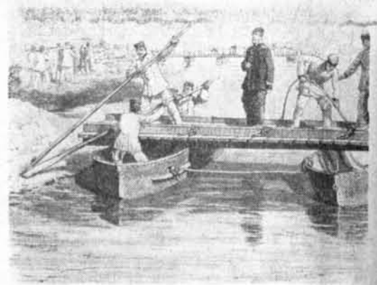
Pioniere beim Bau einer Ponton-Brücke
