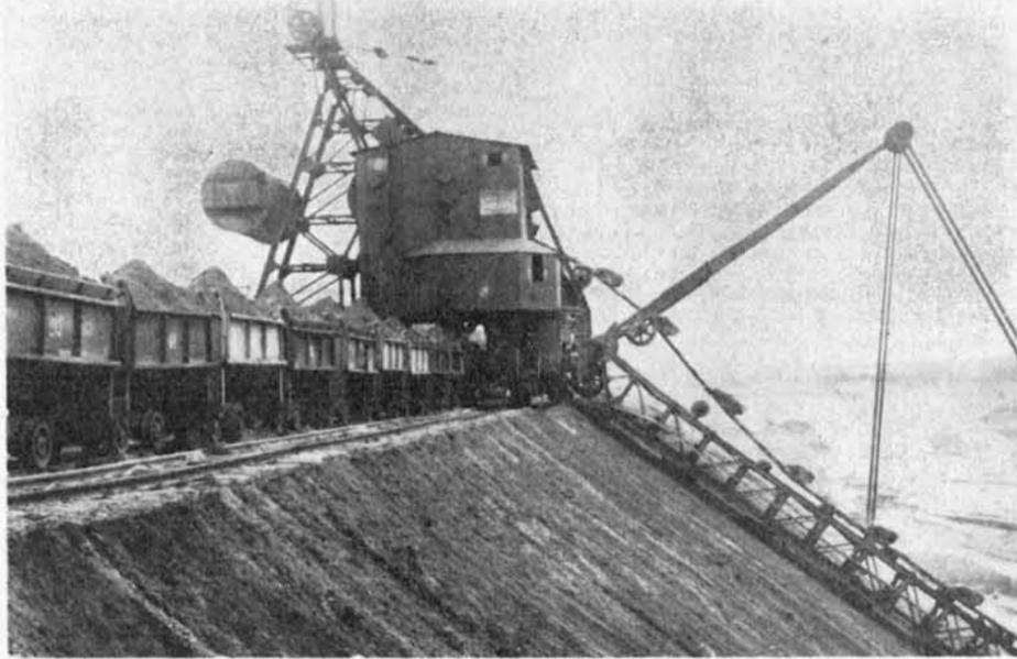
Abraum-Bagger über der Blauen Erde in Palmnick. Solche Bagger räumten auf der obersten Trasse des Bergwerkes (Tagebau) das aus den Eiszeiten stammende diluviale „Deckgebirge“, hier also die lockeren Sande, Kiese oder Tone ab, um leichter an die darunter liegende und im Tertiär entstandene bernsteinhaltige Blaue Erde heranzukommen.
