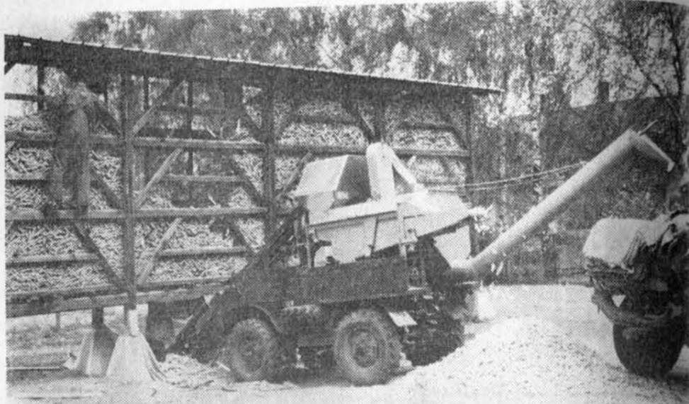
Trocknung von Körnermais im Maschendraht-Gestell; die Entleerung und Weiterverarbeitung im Maisrebler kann man sich erleichtern, wenn man den Unimog mit dem Rebler unmittelbar unter den Behälter läßt und die Kolben mittels Förderband in den Rebler bringt. Werkbild
