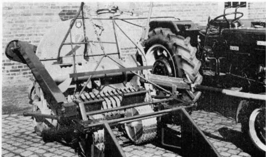
Der zweireihige Köpplapparat am Scheibenrad-Feldhäcksler ermöglicht eine saubere Blätternte. Werkbild
