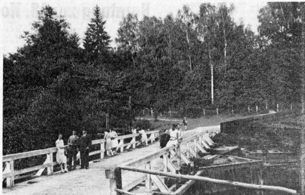
Die Fahrbrücke im Allensteiner Stadtwald
