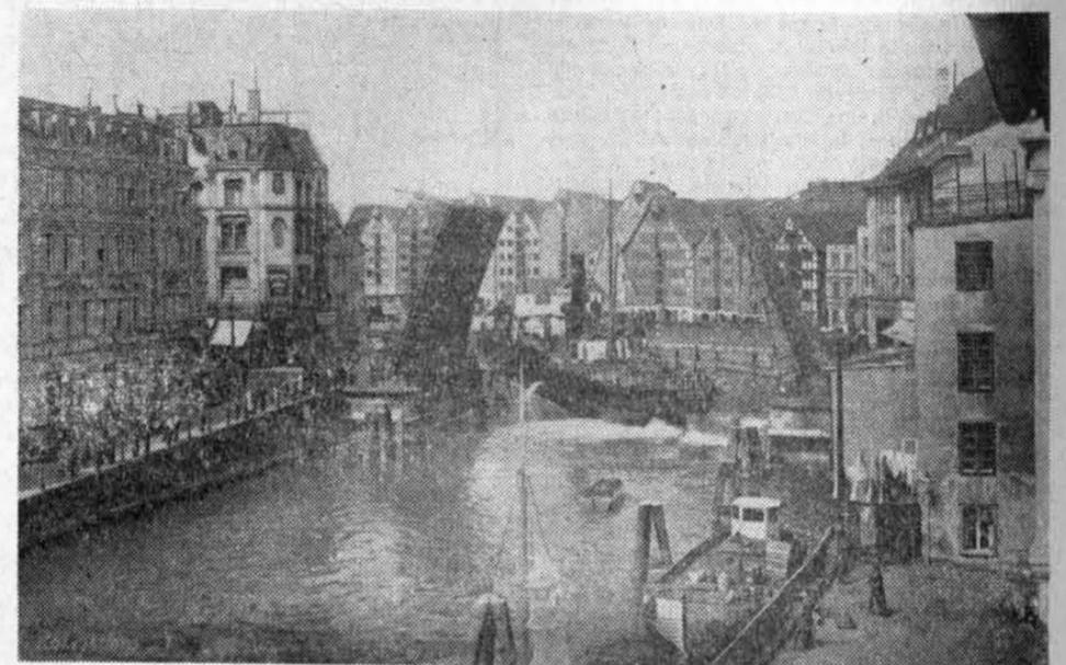
Alle Königsberger Pregelbrücken waren aufklappbar oder drehbar, um Schiffe mit hohen Aufbauten und Masten die Passage zu ermöglichen. Wie sich ein solcher Vorgang abspielte, zeigt dieses Bild von der hochgeklappten Krämerbrücke. Ein Frachter, der vermutlich eine Fracht Holz zur Zellulose-Fabrik auf dem Sackheim gebracht hatte, wendet sich zum Hundegatt, der schmalsten Flußbreite des Pregels.
