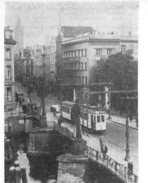
Über den Pregel führten Klappbrücken, die zu bestimmten Zeiten geöffnet wurden, um Schiffe mit hochragenden Masten durchzulassen. Daher konnte kein durchgehender Fahrradweg über die Brücken gespannt werden, und die Straßenbahnen mußten mit aufgespeicherter Kraft diese kurze Strecke überwinden, wie auf diesem Bilde die „3“ auf dem Wege zum Hauptbahnhof über die Grüne Brücke. Aufn.: Schöning
