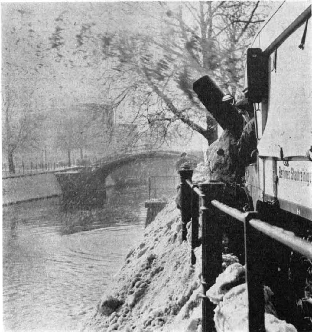
In den Landwehrkanal...
