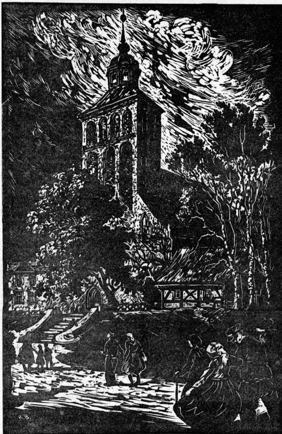
Die Pfarrkirche in Wehlau
