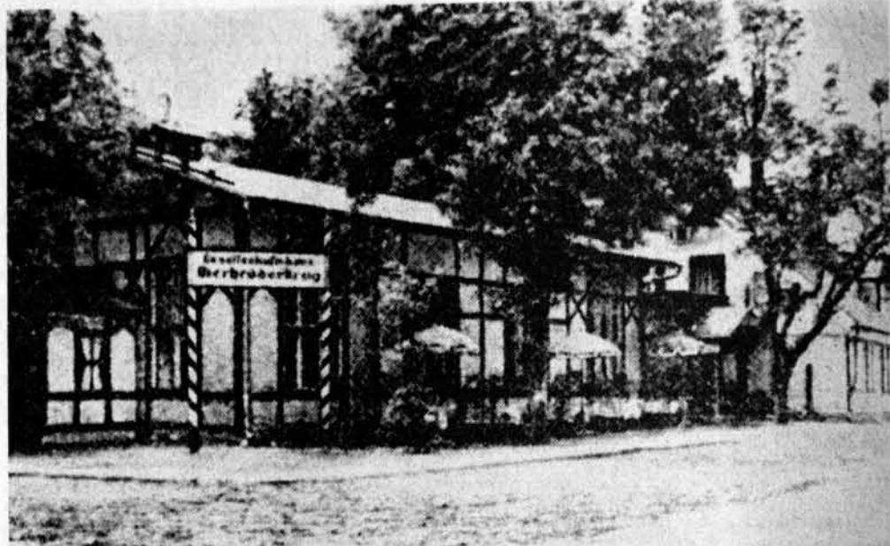
Das alte Gesellschaftshaus Vierbrüderkrug
