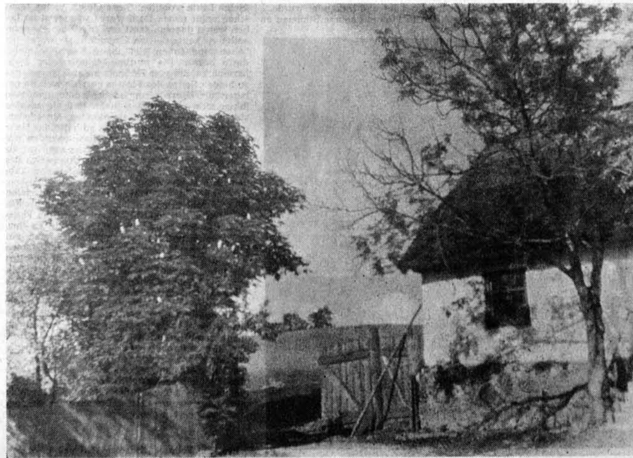
Einfahrt zum Hof in Jakunowken, Kreis Angerburg.
