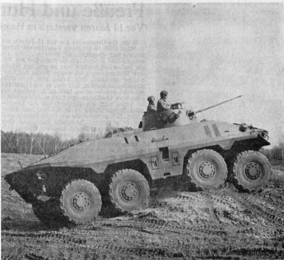
Zur Spitzenklasse unter seinesgleichen zählt der neue Achtrad-Spähpanzer 2, der 1973 bei den Panzeraufklärern der Bundeswehr den veralteten Hotchkiss-Spähwagen ablösen soll. Der neue Spähpanzer hat einen 10-Zylinder-Vielstoff-Dieselmotor von 400 PS-Leistung, wiegt 19 Tonnen und ist schwimmfähig (11 Kilometer pro Stunde). Er trägt vier Mann Besatzung, verfügt über Panzerabwehrraketen und eine neue 20-mm-Kanone von Rheinmetall mit einer Feuergeschwindigkeit von 1000 Schuß pro Minute. Foto: Archiv
