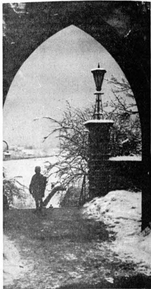
Insterburg: Durchgang zur Angerappbrücke Foto Hallensleben
