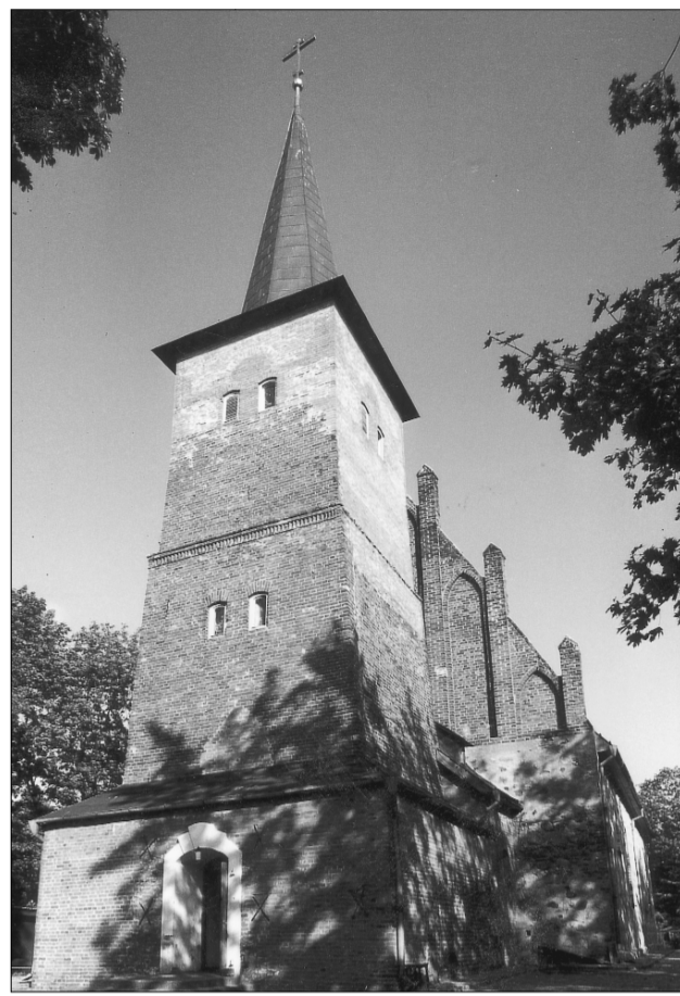
Westfront mit vorgesetztem Turm: Im Gegensatz zum Kirchenschiff ganz aus Backsteinmauerwerk errichtet
