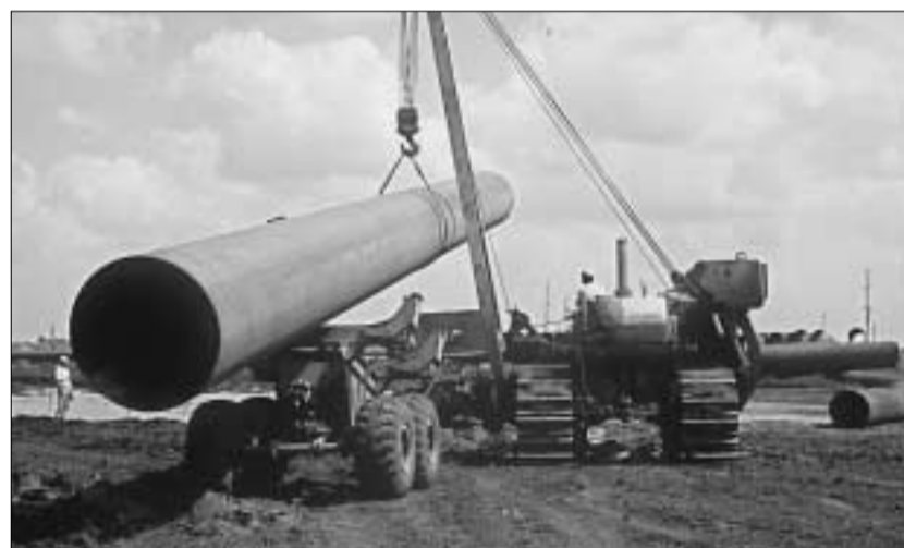
Pipelinebau in Rußland: Nachdem Westeuropa an die Erdöl- und Gasquellen des Kaukasus und Sibiriens angeschlossen ist, baut Rußland sein Netz weiteren aus, auch in Richtung Asien. Das bringt Devisen in die Staatskassen. Foto: dpa
