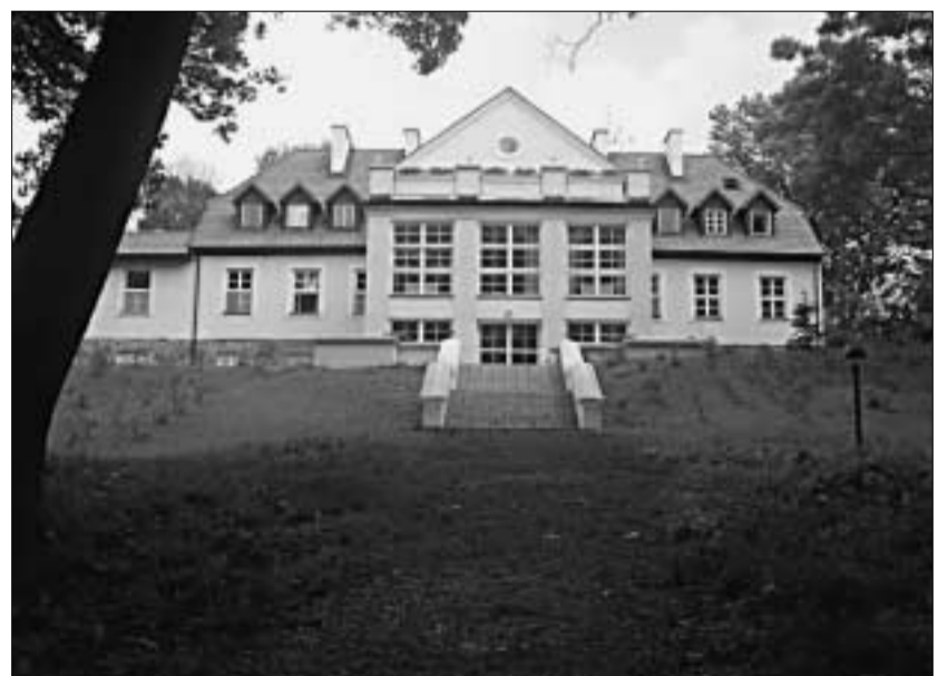
Idylle am See: Eine Freitreppe führt vom Wasser hoch zur Terrasse des Hauses Banners, das zu erholsamem Urlaub einlädt.
