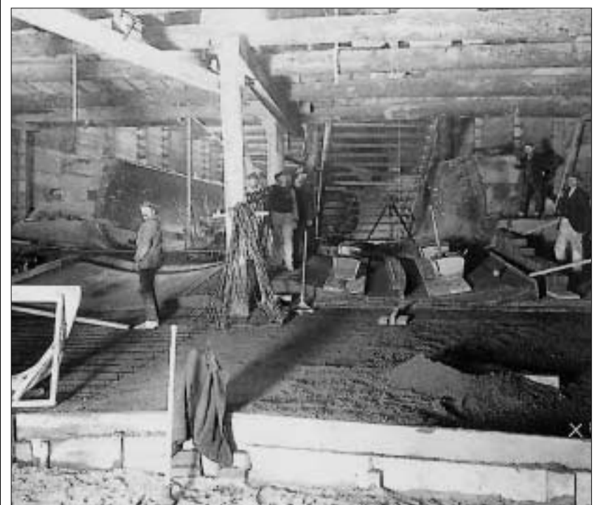
Berlin 1907: Bau der Kanalisation unter dem Alexanderplatz
