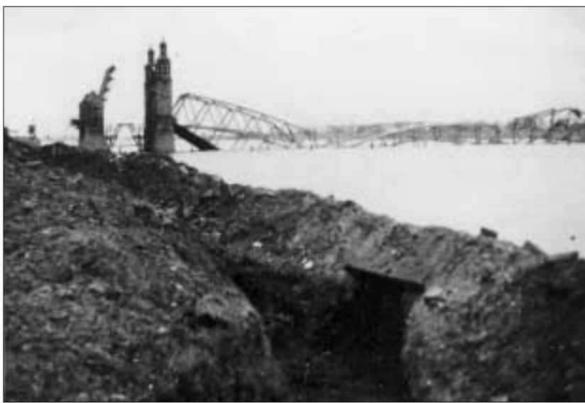
Verteidigungsstellung am Tilsiter Memelufer: Nach der Sprengung der Königin-Luise-Brücke Foto: Kragening's
