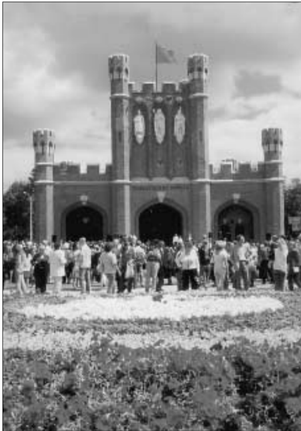
Frisch restauriert: Das Königstor nach der Enthüllung
