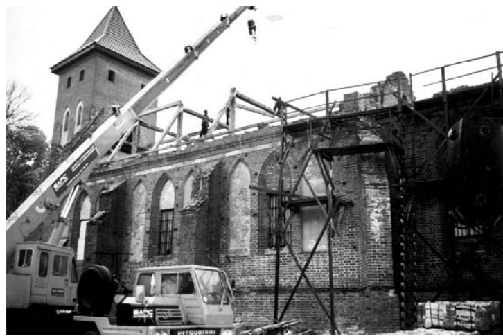
Montage des Dachstuhls auf der Katharinenkirche in Arnau
