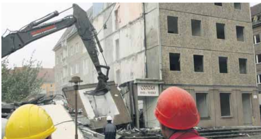
Ganze Quartiere planiert: Wegen des Bevölkerungsschwunds in Brandenburg stehen einst dringende benötigte Plattenbaudispositionen leer und werden wie hier in Prenzlau abgerissen.
