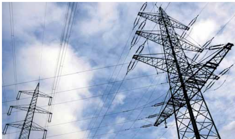
Das deutsche Stromnetz ist 1,6 Millionen Kilometer lang. Nur knapp 25 Prozent davon verlaufen noch oberirdisch.
