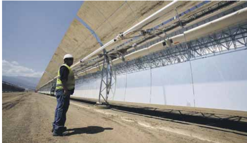
Solarfeld in Andalusien: Am Rande der Sierra Nevada haben spanische und deutsche Ingenieure das größte Solarwärmekraftwerk Europas gebaut.
