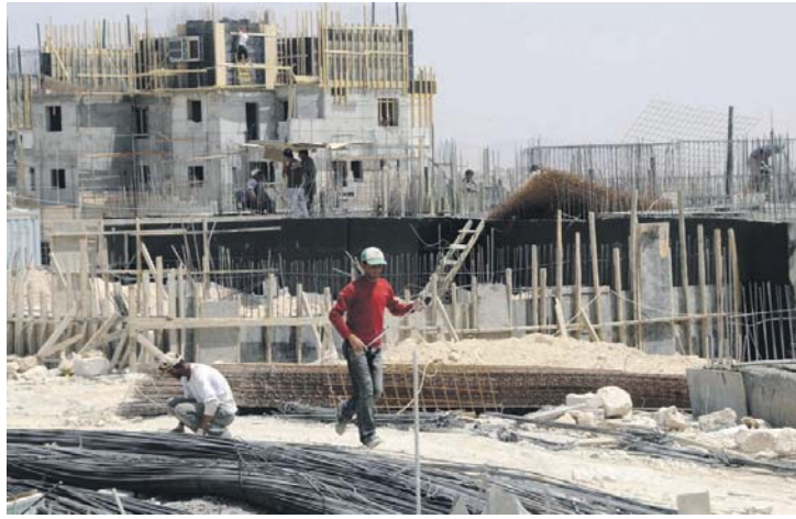
Der Bau schreitet voran: Bauarbeiten in der Siedlung Maale Adumim bei Jerusalem
