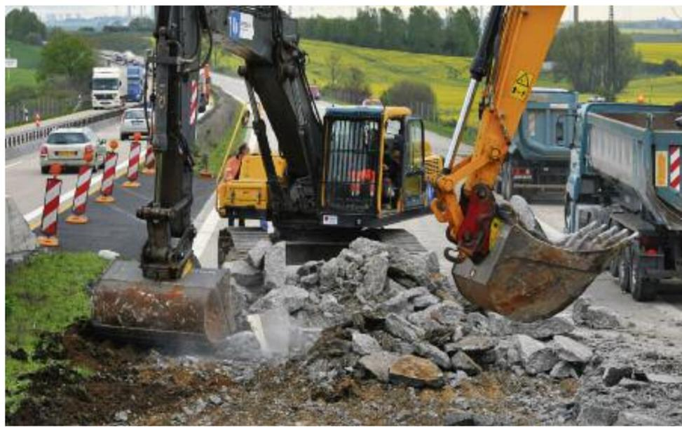
Immer mehr Baumängel: Arbeiter erneuern Fahrbahn, die vom „Betonkrebs“ befallen ist. Bild: pa
