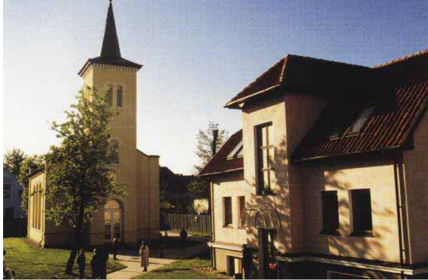
Salzburger Kirche und Diakoniezentrum „Haus Salzburg“ in Gumbinnen; Mit der Wiederrichtung der 1840 gebauten Kirche im Jahre 1995 und dem Bau des „Hauses Salzburg“ 1998 sind dem Salzburger Verein beispielgebende Aufbauwerke im Königsberger Gebiet gelungen.
