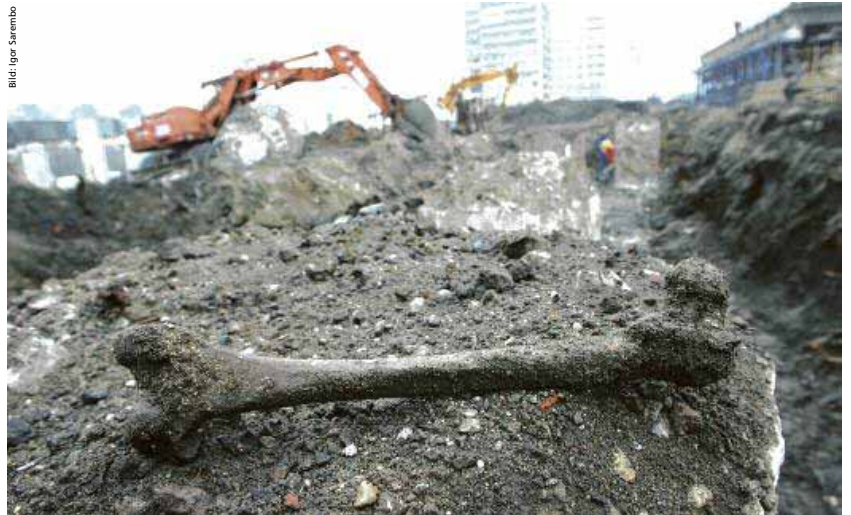
Großbaustelle Königsberg: Menschliche Überreste zeugen von in der Sowjetzeit überbauten Friedhöfen.
