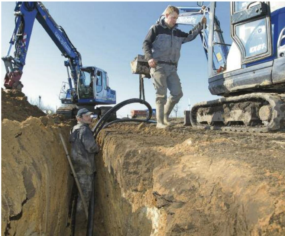
Von Kabeln wird heutzutage viel verlangt: Kostenintensive Verlegung kombinierter Erdkabel zur Breitbandversorgung mit DSL-Internet und zum Stromabtransport eines Windparks
