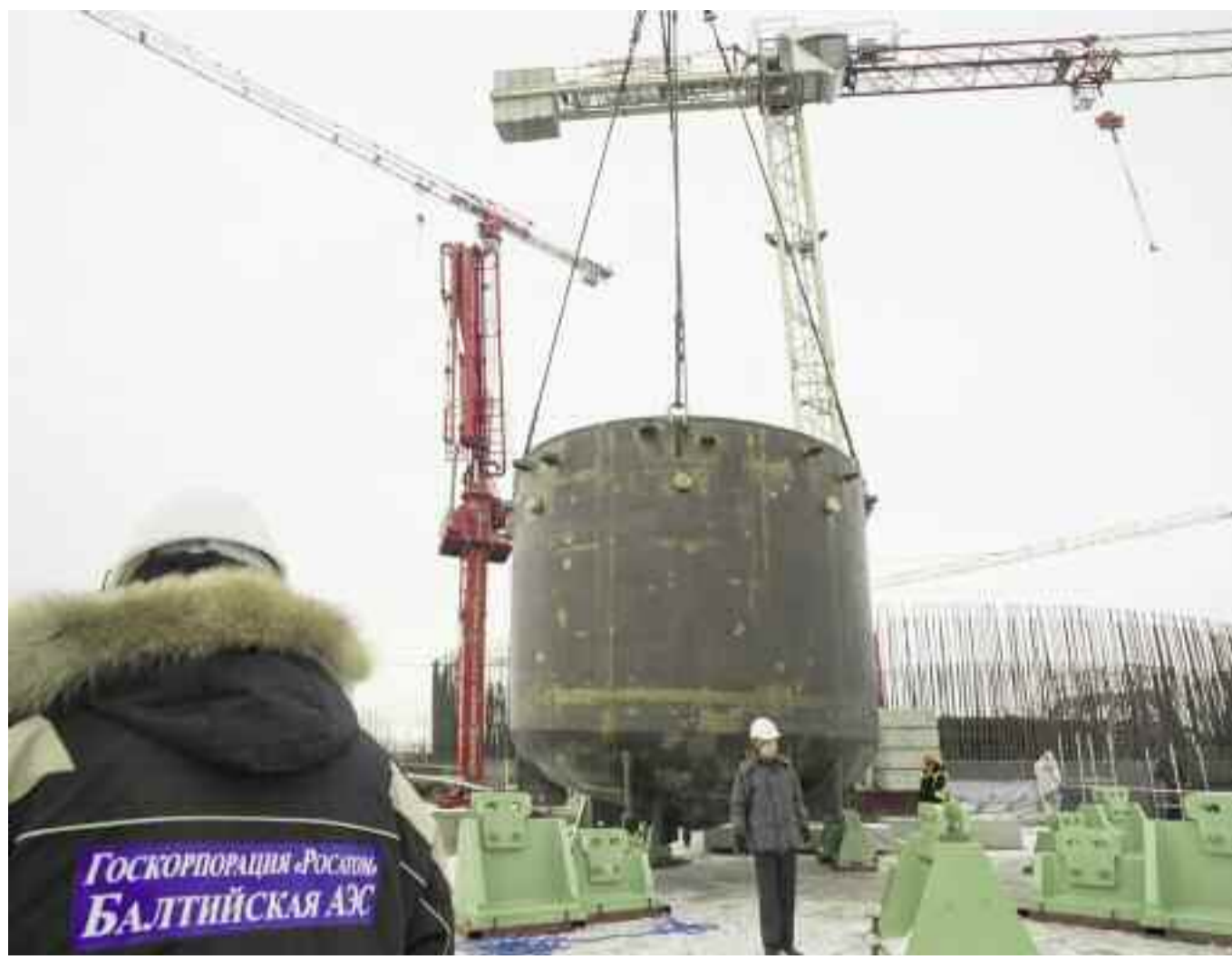
Nur eine weitere Bauruine von Rosatom? Der Bau des Kernkraftwerks „Baltijskaja“ wurde gestoppt
