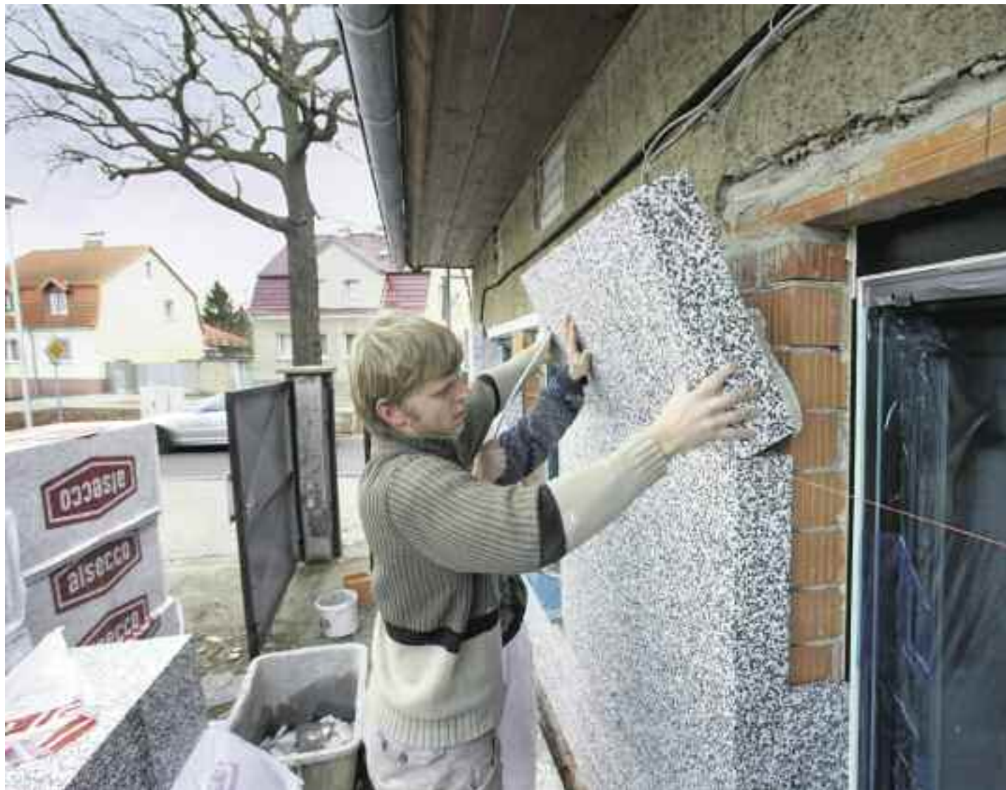
Die natürlichen Eigenschaften des Mauerwerks missachtet: Nicht immer sind Sanierungen sinnvoll
