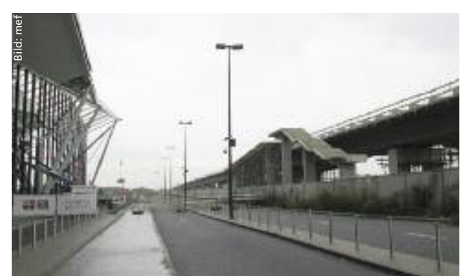
Flughafenterminal: Haltepunkt der neuen S-Bahn
