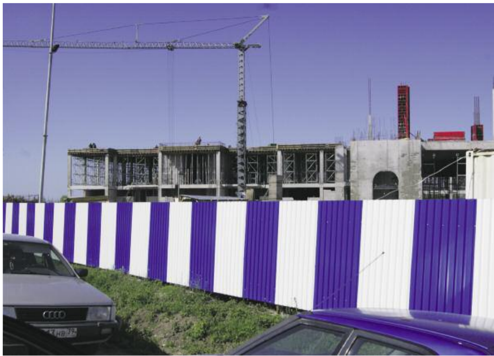
Hässlicher „Bernstein“: Die nach dem Gold des Meeres benannte und im Bau befindliche „Erholungsstadt Jantarny“ in der Gemarkung Garbseiden verschandelt einen weiteren Küstenabschnitt des nördlichen Ostpreußen
