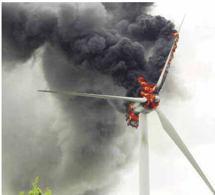
Totalschaden in einem Windpark bei Buxtehude: Brände gehören zu den häufigsten Unfallursachen
