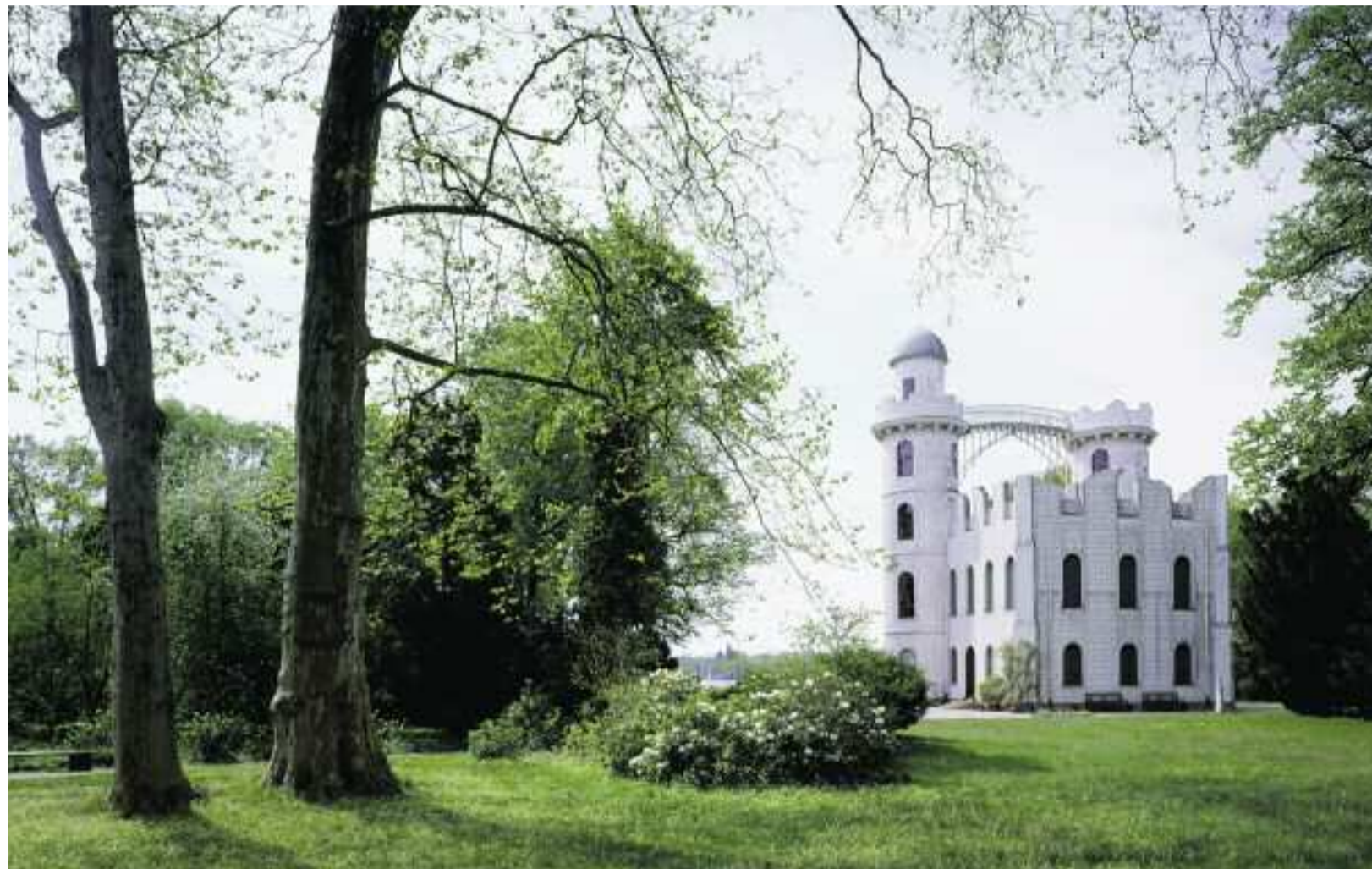
Nur noch bis 19. August für Besichtigungen geöffnet: Schloss Pfaueninsel wird danach umfassend saniert
