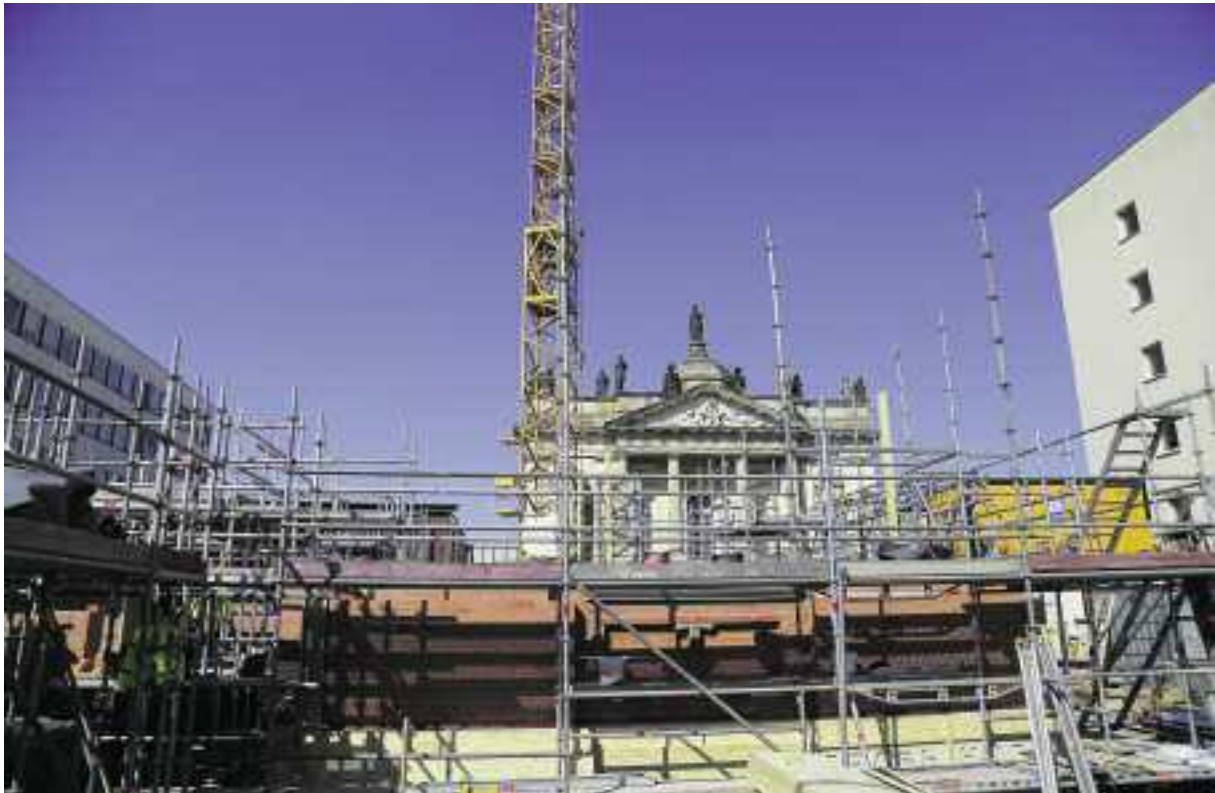
Der Sockel ist fertig: Alles steht bereit für den Turm der Garnisonkirche
