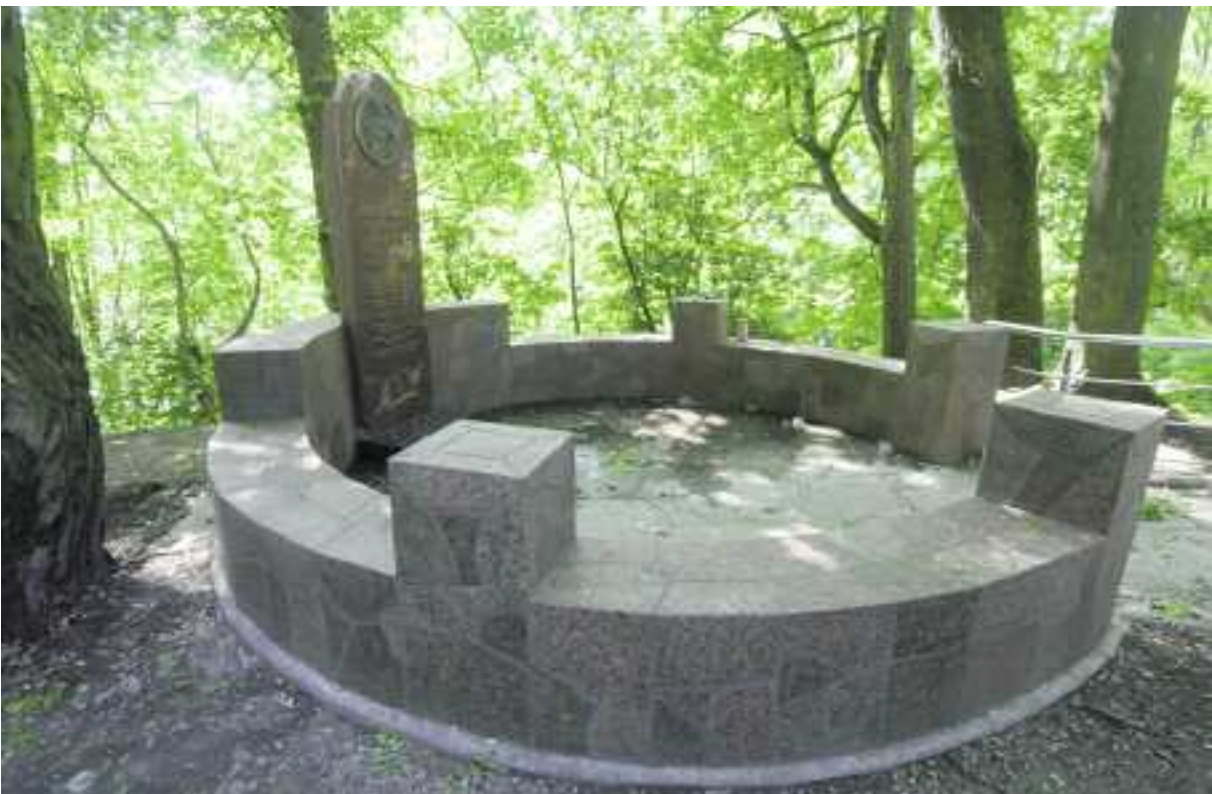
Professorendenkmal: Die Schäden wurden beseitigt
