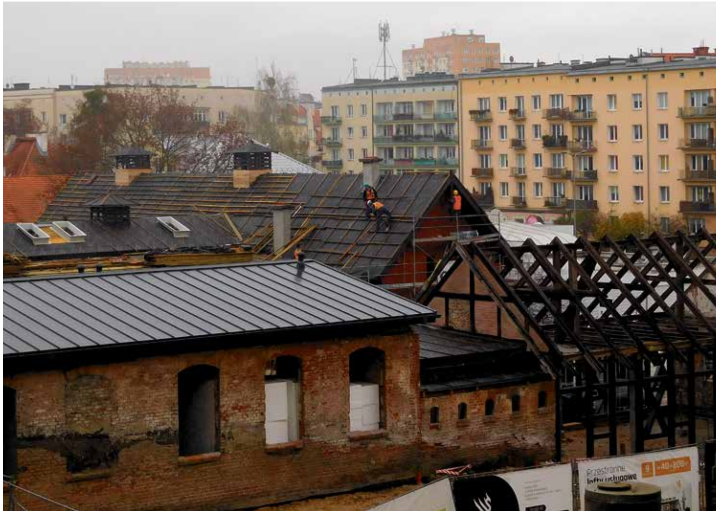
Sanierung in Anlehnung an die historischen Vorbilder: In Allenstein entstehen moderne Büros und Appartments
