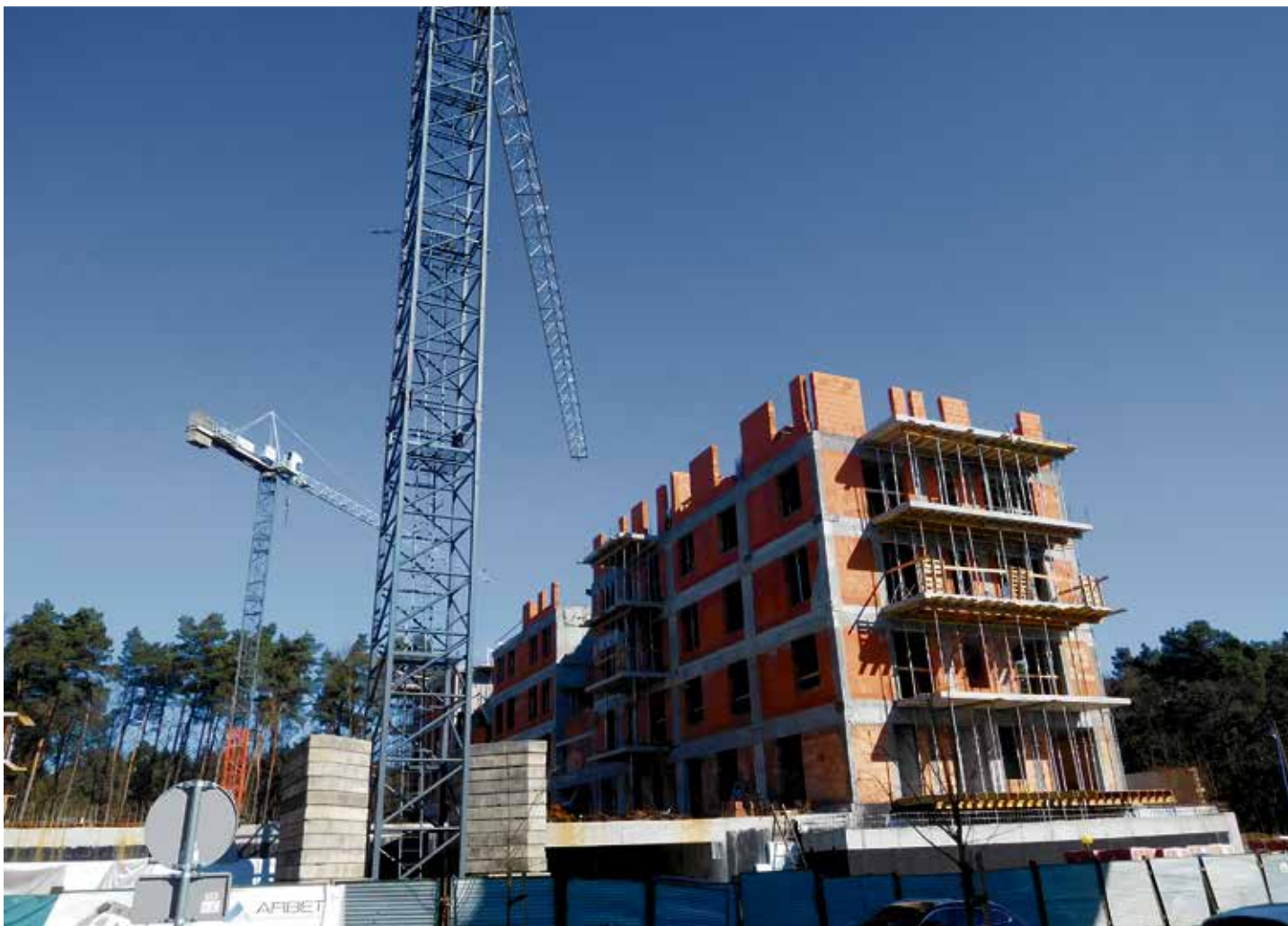
Arbeitskräfte gefragt: Bisher fehlten vor allem auf den Baustellen der Stadt Fachkräfte
