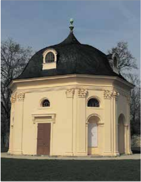
Bereit für Musik: Das sanierte Schallhaus
