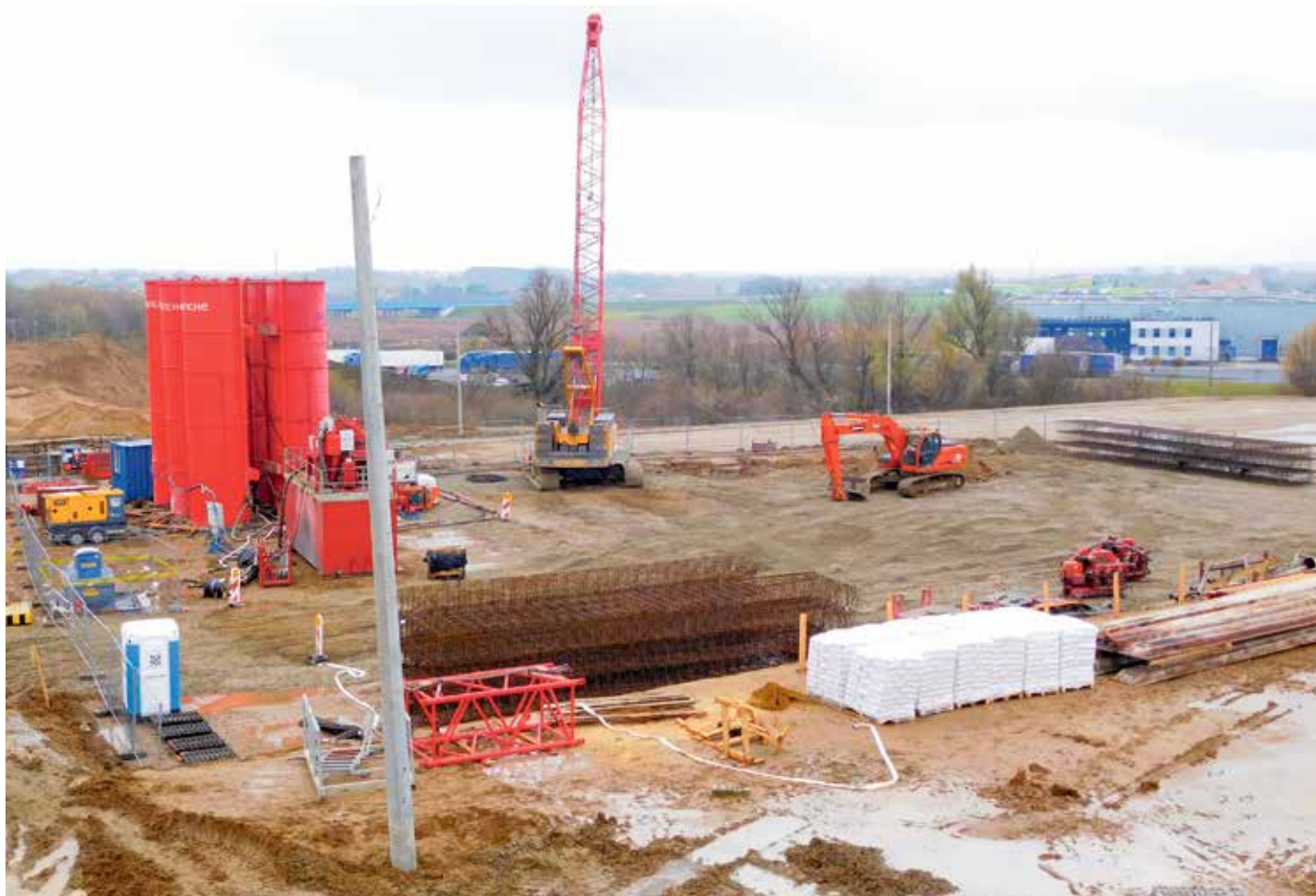
Hier entsteht ein neues Heizkraftwerk: Baustelle in der Karl-Boensch-Straße
