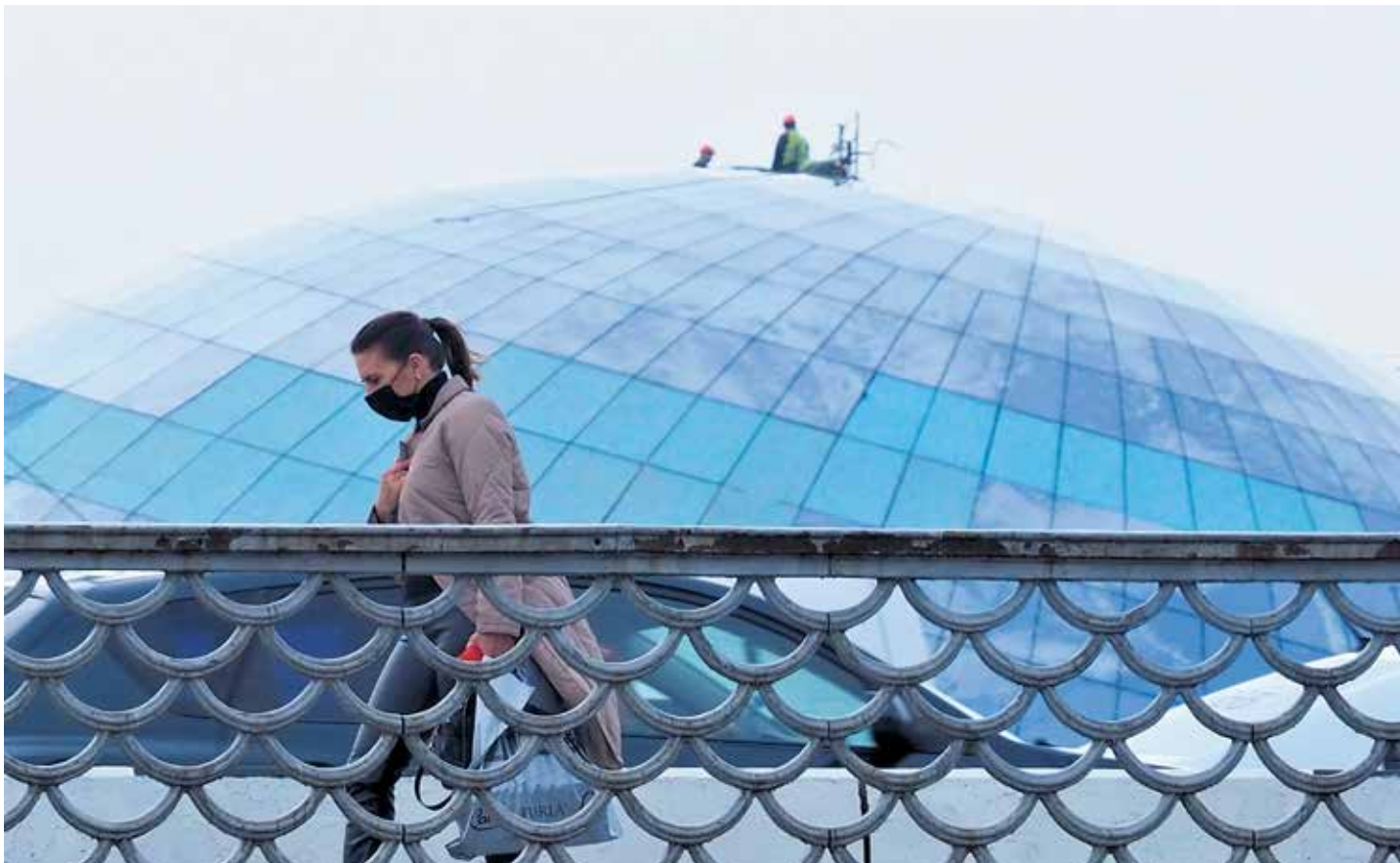
Letzte Arbeiten an der Kuppel des Gebäudes „Planet Ozean“: In dem neuen Nebengebäude des Ozeanmuseums im Zentrum Königsbergs sollen bald Aquarien und neue Ausstellungen unter der Kuppel gezeigt werden
