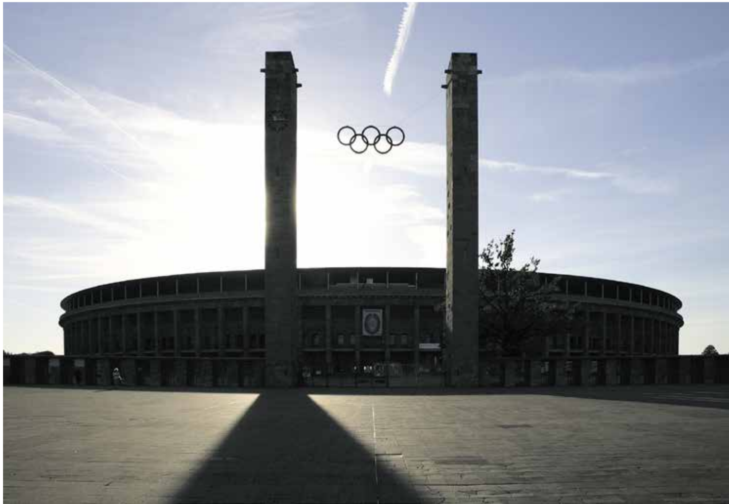
Wurde von 1934 bis 1936 für die Spiele der XI. Olympiade vom 1. bis 16. August 1936 errichtet: Das Olympiastadion Berlin
