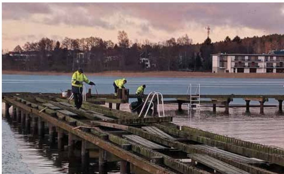
Vorbereiten auf die neue Saison: Abriss des alten Stegs am Okullsee
