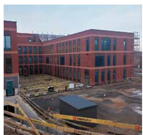
Moderner Ausbau: Uni in Allenstein
