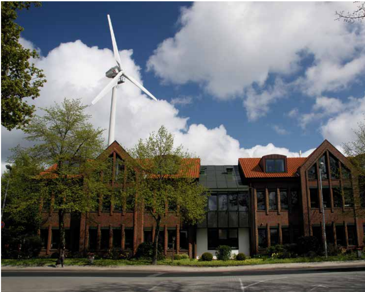
Als Folge eines Cyber-Angriffs am ersten Tag des Ukraine-Krieges hatte Enercon keinen Zugriff mehr auf die Steuerung seiner Windturbinen: Der Hauptsitz des 1984 gegründeten größten deutschen Herstellers von Windenergieanlagen in Aurich
